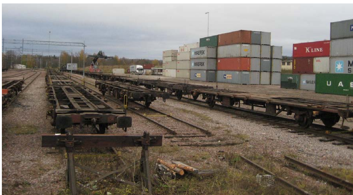
Figur 31 Terminalen i Insjön består av tre spår med ca 150 meters längd vilket begränsar antalet vagnar som kan hanteras till elva åt gången. Foto: Fredrik Bärthel, 2009-10-23.
