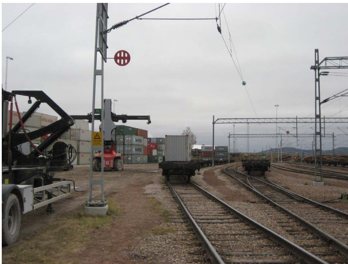
Figur 32 Terminalen i Insjön har anslutits med kontaktledning in till hanteringsytan. Det medför att Green Cargo slipper ha ett diesellok stationerat i Insjön, men växlingen är ändå en begränsande faktor då ellok endast befinner sig vid terminalen vid två tillfällen varje dygn. (Foto: Fredrik Bärthel, 2009-10-23).
