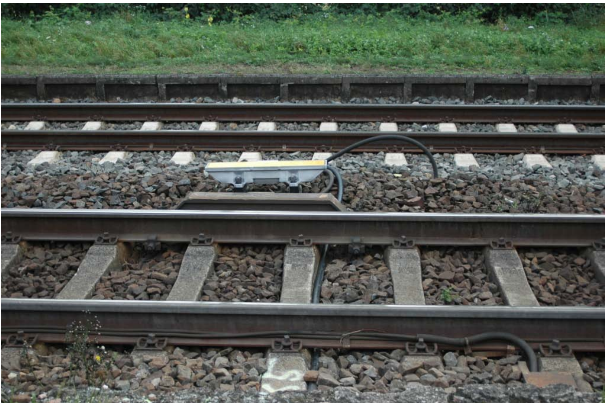
Kabeldragning vid grening av kabel. Föremålen på utsidan av de båda spåren är baliser hörande till tågövervakningssystemet PZB.
