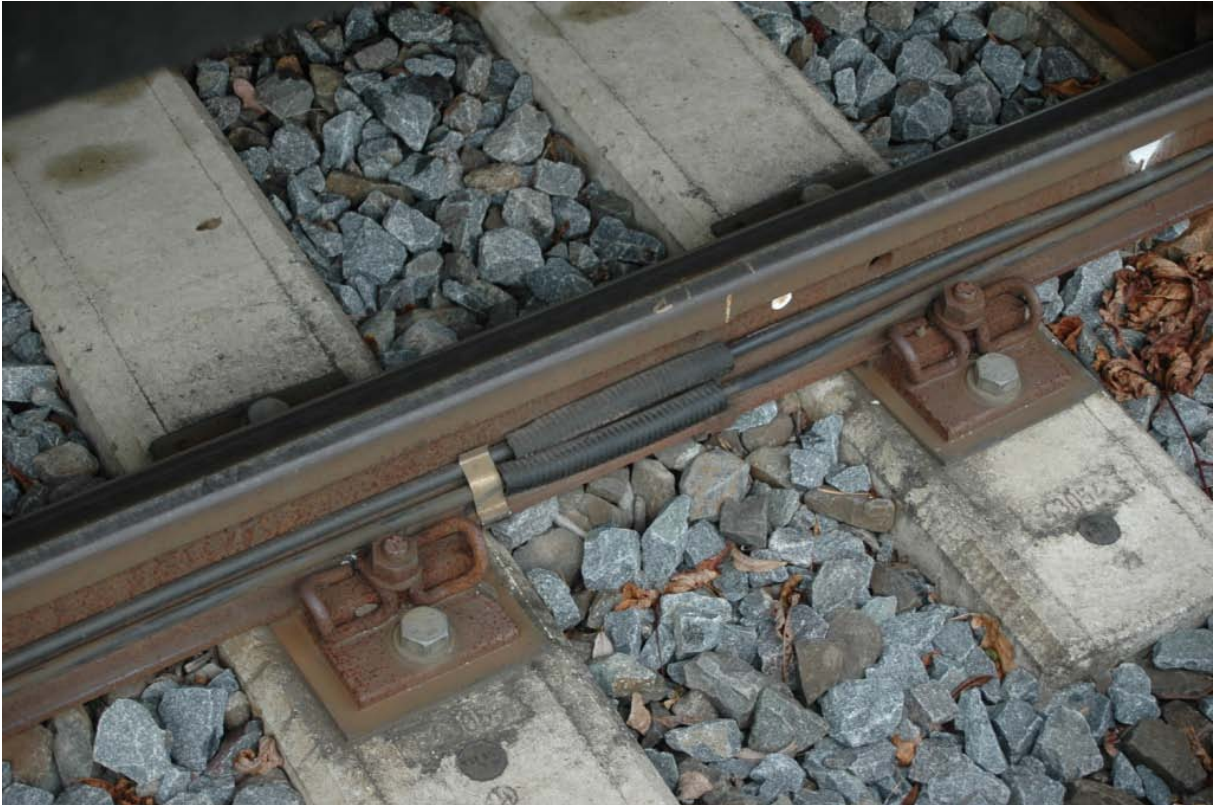
Placering av kabelskarvar
