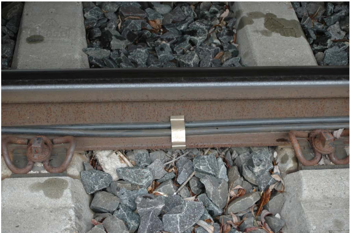
Befästning av signalkablar med clips
