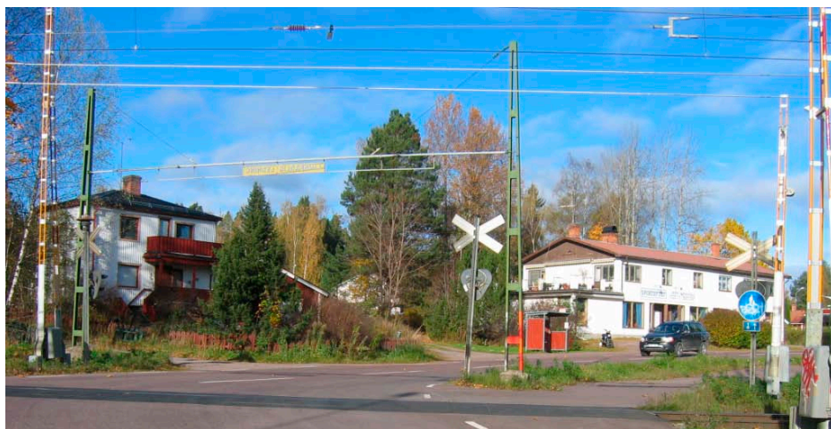
Foto 7.3. Befintlig plankorsning i norra delen av Ornäs.
