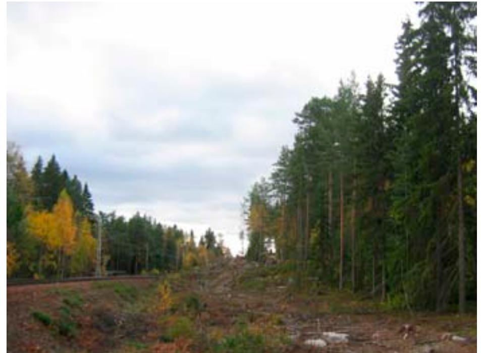
Figur 3.2. Träd nära järnväg fälls inom projektet ”Trädsäkra järnvägar” för att minska störningar av fallande träd över spår.
