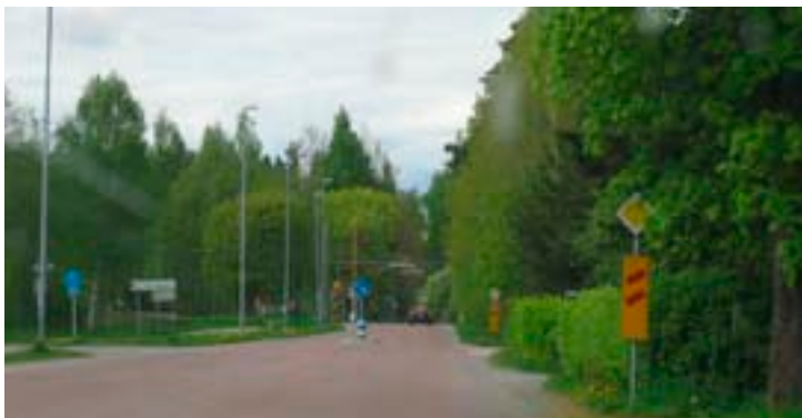
Bild 15. Hagaströmsvägen i Norra Valbo, järnvägen breddas vilket påverkar gatuutrymmet och angränsande fastigheter.
