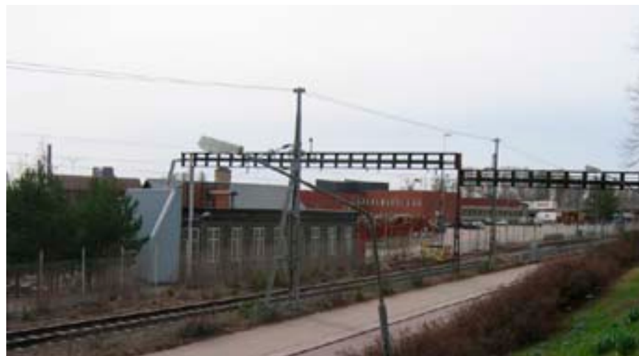
Bild 7.3. På en del av sträckan i alternativ Sandvikens östra del ligger Mossvägen med gång- och cykelbana parallellt med järnvägen. Vägrummet begränsas av järnvägen i söder och av en slaggstensmur och Sandvikens huvudkontor i norr.
