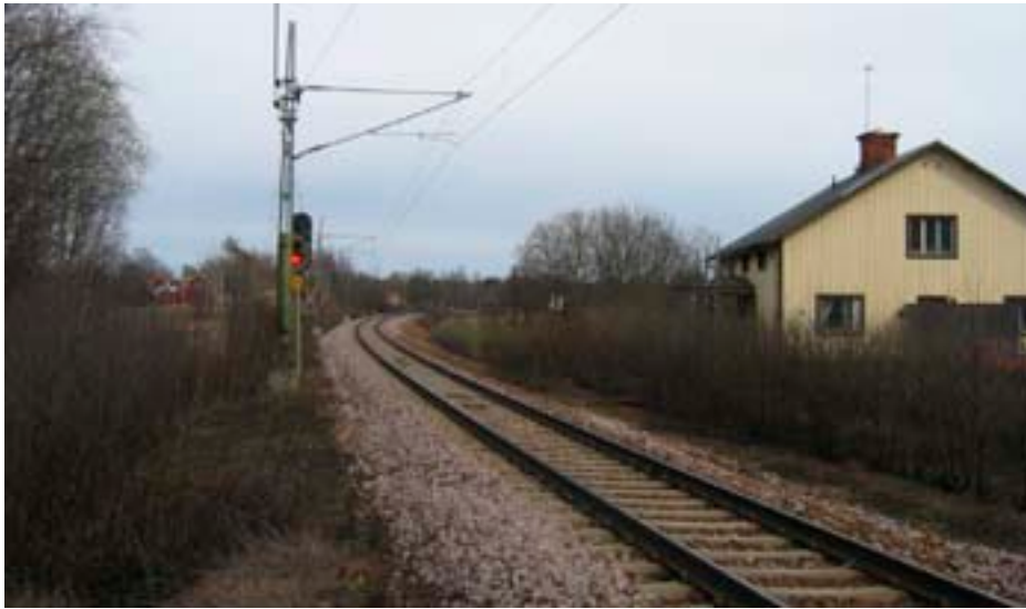
Bild 7.6. I östra delen av sträckan ligger en friliggande villa i direkt anslutning till järnvägens plankorsning med en lokalväg.
